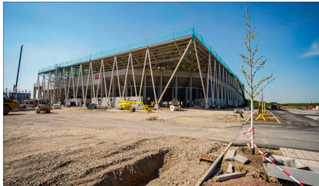
Weit fortgeschritten: Das neue Stadion ist im Rohbau fast fertig; auch die Außenanlagen sind weit fortgeschritten. Ob die Gesamtfertigstellung bis zum Sommer klappt, hängt aber auch davon ab, ob alle Bauteile rechtzeitig geliefert werden können. (Foto: A. J. Schmidt)
