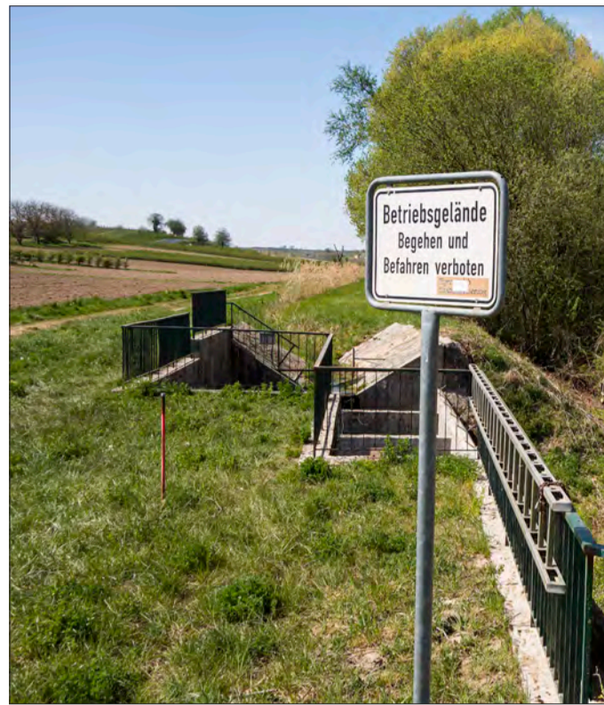
Besserer Schutz für Opfingen: Oberhalb der Ortschaft wird jetzt das Regenrückhaltebecken ertüchtigt. (Foto: A. J. Schmidt)
