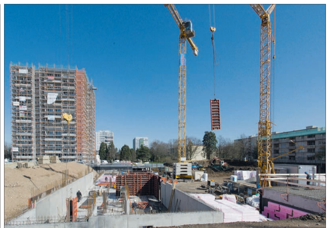
Die Grundmauern sind bereits erkennbar: Zwischen der Opfinger Straße und dem Binzengrün entstehen derzeit drei Gebäuderiegel mit insgesamt 80 Wohnungen. Im Hintergrund links das in Sanierung befindliche Hochhaus Binzengrün 36. (Foto: A. J. Schmidt)
