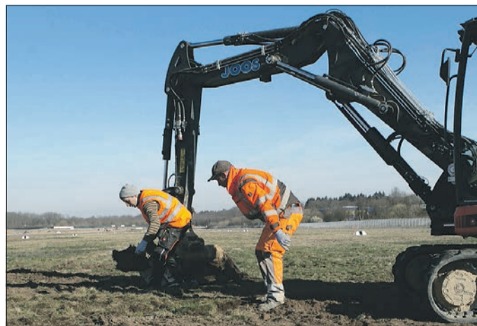
Unter den Teppich gekehrt: Zum Auffüllen der Löcher in der neuen Grasbahn wird der wertvolle Magerrasen vorsichtig abgehoben und anschließend wieder verlegt. (Foto: A. J. Schmidt)
