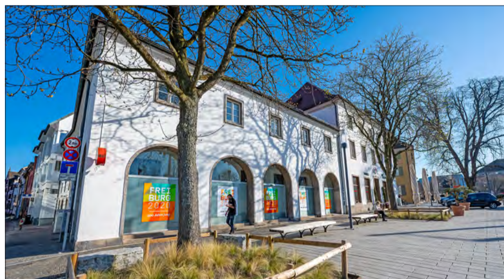
Zukünftiges Dokumentationszentrum: Ab Sommer 2022 wird der Gebäudekomplex des ehemaligen Verkehrsamts am Rotteckring und des Rotteckhauses umgebaut. (Foto: P. Seeger)
