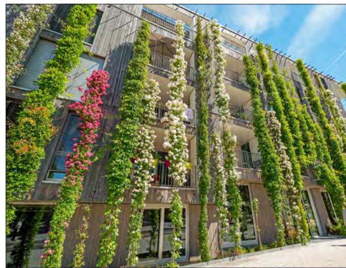
Vorbildlich und schön: Die grüne Fassade am Green City Hotel im Stadtteil Vauban. (Foto: P. Seeger)
