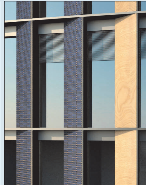
Ein ringförmiger Flur erschließt die Büros in den Obergeschossen, die Treppen und Aufzüge sind im Bereich der Ecken untergebracht (links); die Fassade (rechts) ist mit Holz- und Solarpanel-Elementen gegliedert.
