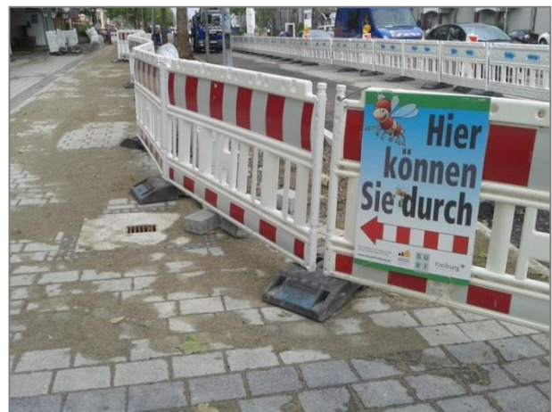
Abbildung 13: Gutes Beispiel für die gleichmäßige Ausrichtung der Aufstellvorrichtungen. Freiburg, Sundgaullee, Juni 2016 (Quelle: eigenes Foto)
