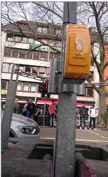
Abbildung 20: LSA mit Daueranforderung und ZEB, Freiburg, Mai 2017 (Quelle: GuT)
