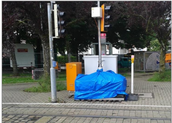
Abbildung 19: LSA ohne Zusatzeinrichtungen für Blinde. Schwer erreichbar für Menschen im Rollstuhl. Freiburg, Sundgaubrücke, Juni 2016 (Quelle: eigenes Foto)
