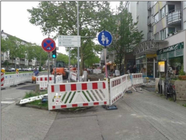
Abbildung 23: Unklare Beschilderung und Wegeführung, ist der Notweg rechts über den Gehweg oder links über die Fahrbahn? Freiburg, Sundgauallee, Juni 2016 (Quelle: eigenes Foto)
