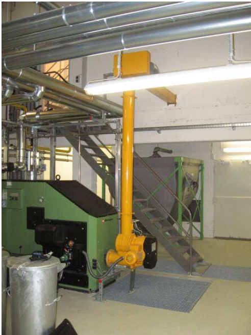
Abb. 32: Holzpelletkessel in den Berufsschulen, Friedrichring
