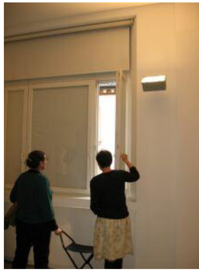
Abb. 8 u. 9: Begehung des Museums für Neue Kunst – fehlende äußere Verschattung und Halogenstrahler führen zu hohen Innenraumtemperaturen und hohen Energiekosten
