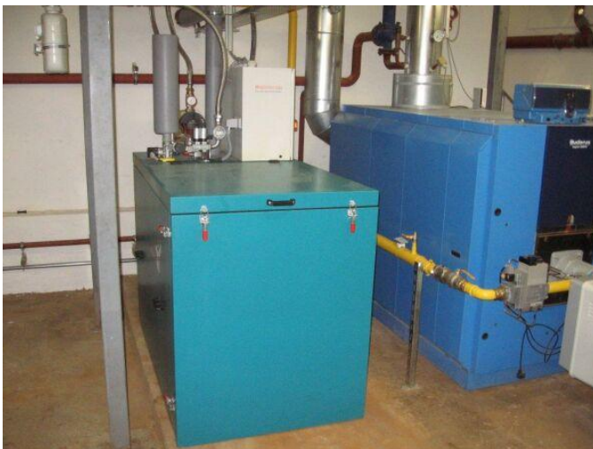
Abb. 33 u. 34: Neues BHKW im Lycee-Turenne und Anzeige der Betriebsdaten auf dem Display
