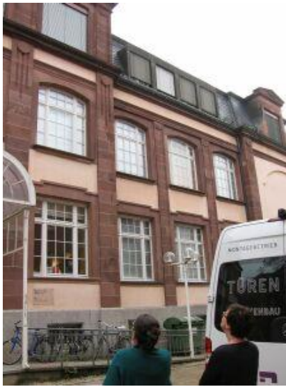
Abb. 8 u. 9: Begehung des Museums für Neue Kunst – fehlende äußere Verschattung und Halogenstrahler führen zu hohen Innenraumtemperaturen und hohen Energiekosten
