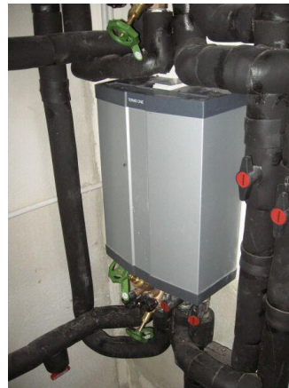
Abb. 10 u. 11: Duscharmaturen sowie auf der Rückseite der Installationswand befindliche Frischwasserstation
